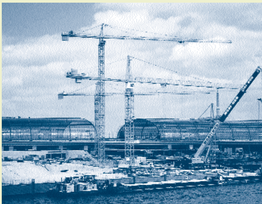
Construction de la future gare centrale.
