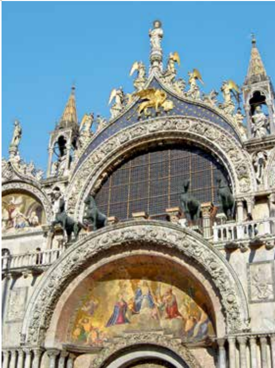
Vue sur la loggia extérieure de la basilique Saint-Marc, située au niveau des quatre chevaux sculptés ■ A.V.
