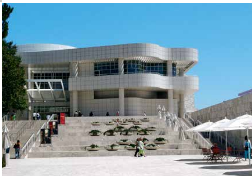
Un des bâtiments du Centre Getty ■ R. Ghio
